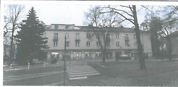
Fot. 1 Widok ogólny budynku
