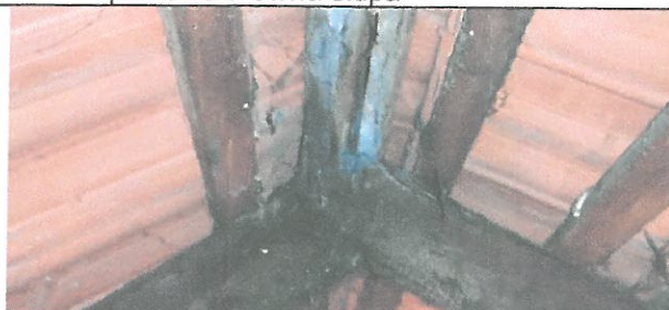
Fot. 11 Widok strychu – łączenie krokwi w kalenicy
