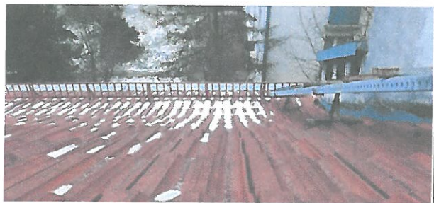
Fot. 3 Widok pokrycia
